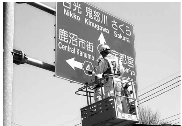
写真：設置工事の様子
