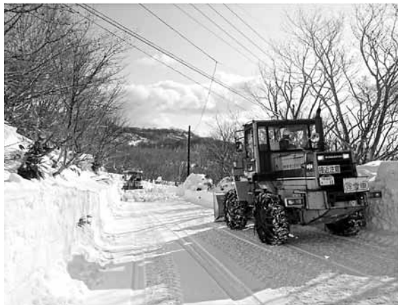
写真：除雪作業の様子
