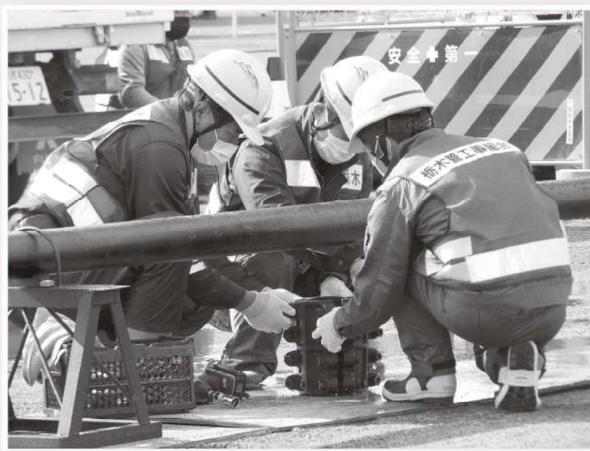
令和4年度 栃木県・栃木市総合防災訓練における復旧作業の様子（栃木市公認管工事業協同組合）
